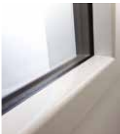
Glaçage du profil PVC.
