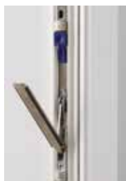
Verrouillage du vantail secondaire.
