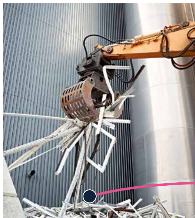
Collecte des anciennes menuiseries PVC.
